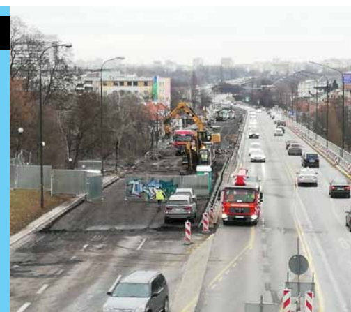
W weekend ruszył kolejny etap remontu Trasy Łazienkowskiej
